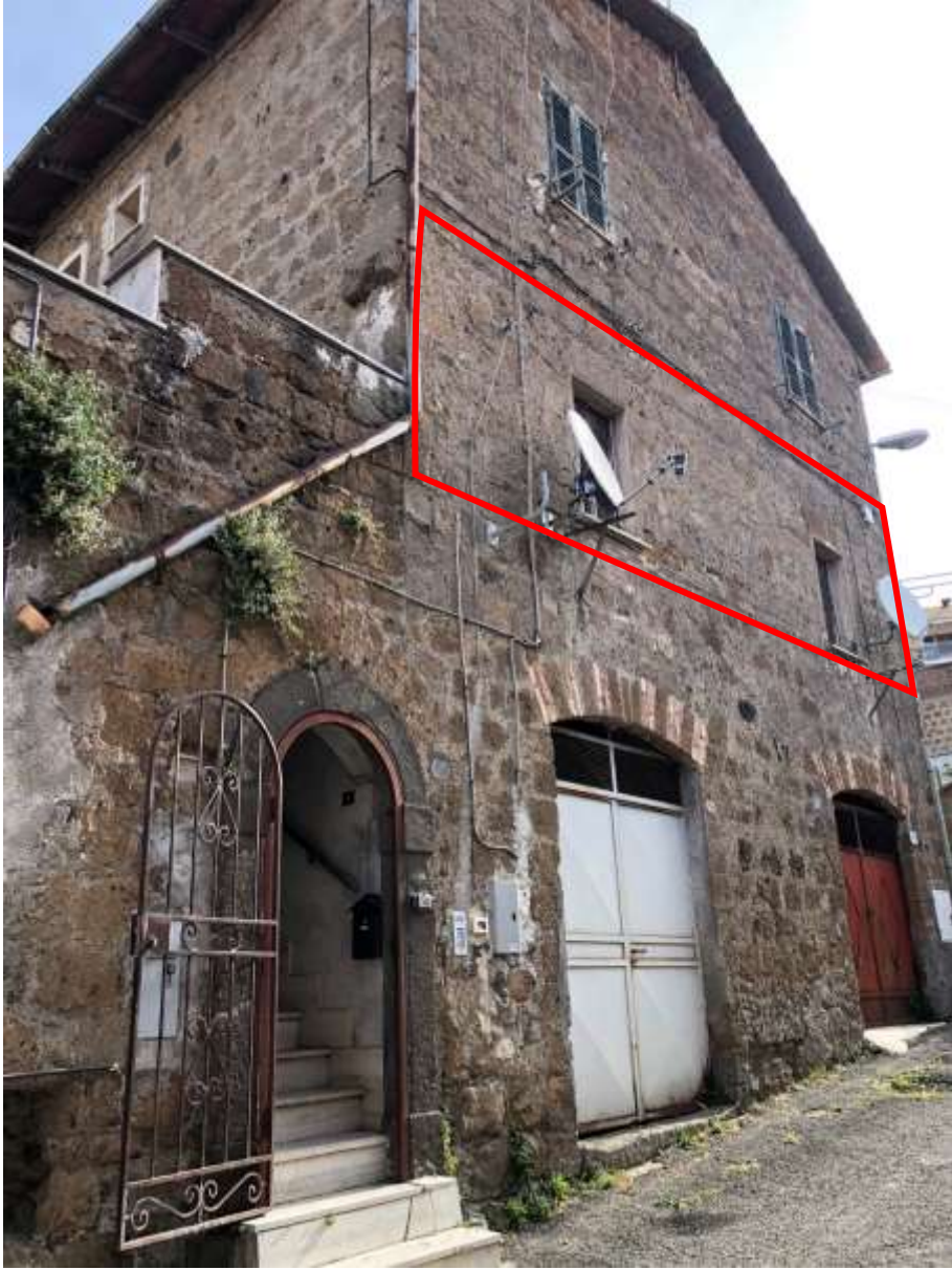
Foto 1 Prospetto su via Ugo Foscolo con cancelletto e scala di ingresso.
