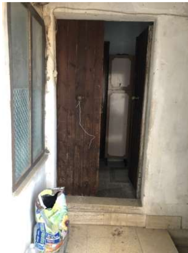
Foto 3 Portone di accesso al piano primo
